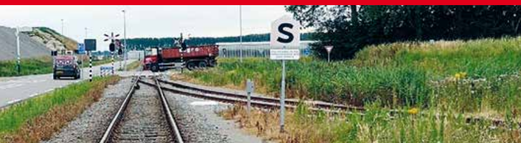
Een klein gedeelte van de in stand te houden spoorinfrastructuur
